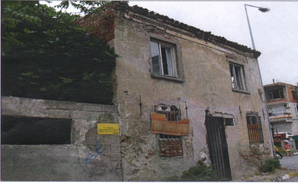
6199 PARSELDE YER ALAN YAPI
