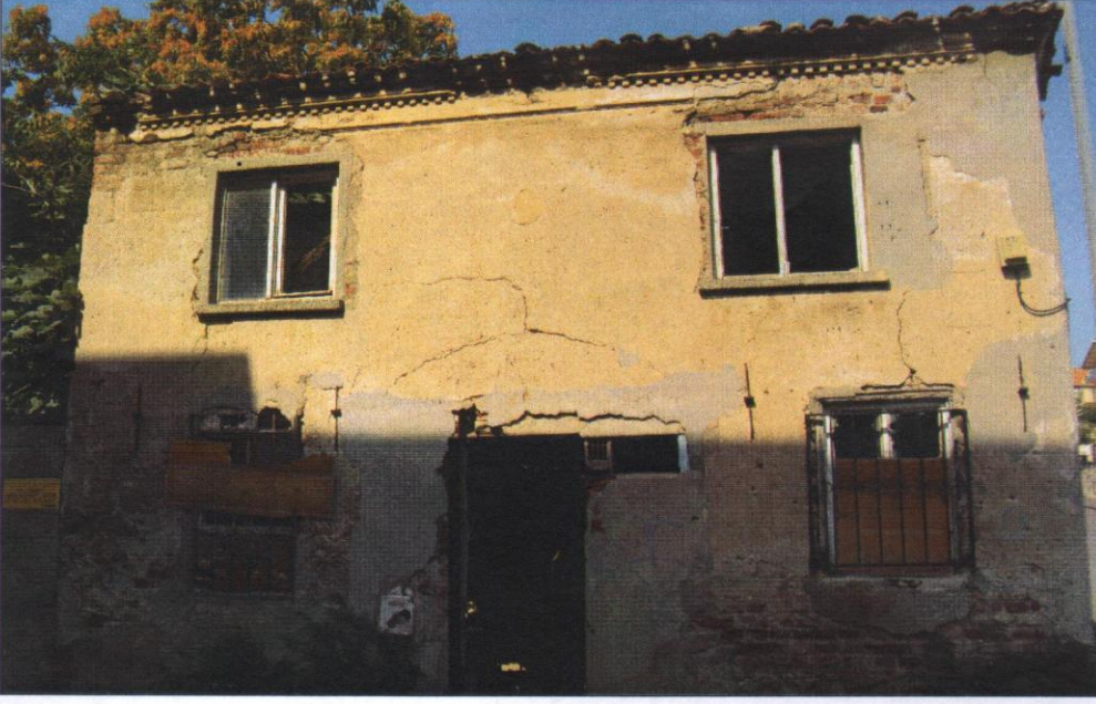
6199 PARSELDE YER ALAN YAPI
