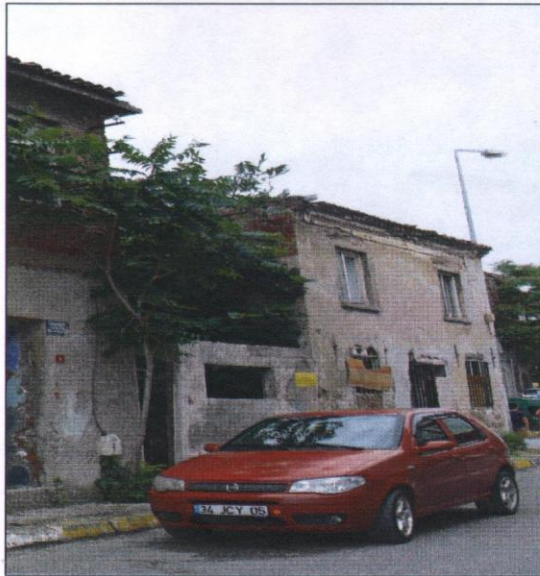
6199 PARSELDE YER ALAN YAPININ TUĞLA ÖRGÜLÜ BATI CEPHESİNDEN GÖRÜNÜM
