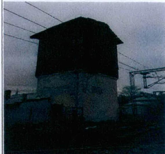
**AYRINTILI TANIM:** Su kulesi taş zemin üzerine ahşap kule ve kule ile bitişik nizamlı tek kath, dikdörtgen planlı beşik çatılı bir yapı bulunmaktadır. Kule kare planlı olup, üst bölümünden kullanılmayan su tankı bulunmaktadır. Yapıya batı cephede yer alan basık kemerli bir yapı ile girişmektedir. Doğu cephede basık kemerli bir adet pencere yer almaktadır. Yapıya bitişik nizamda niteliksiz müstemilat yapıları yer almaktadır.
